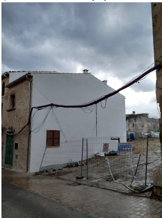
Fotografia 2. Accés a l'aparcament del carrer Major. L'edificació del núm. 26 (a l'esquerra de la fotografia) es destinarà a equipament.
